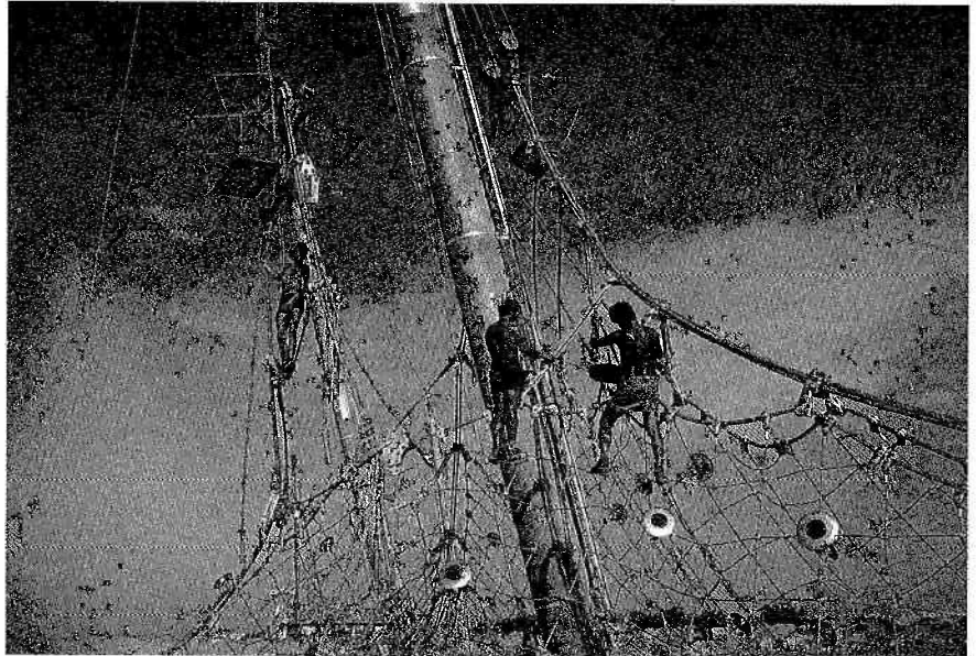
Fig 1.13 Cable net erection - Jeddah 1979
